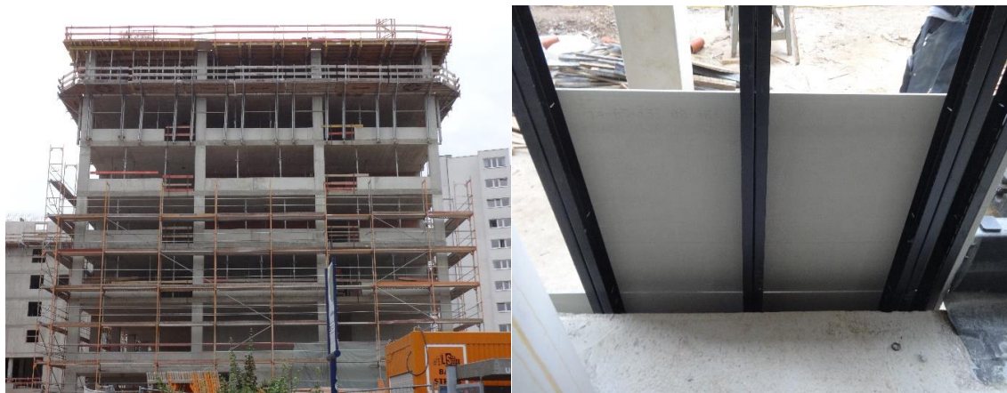
Figura 2 - Vista frontal de uma das torres e detalhe da instalação de perfis e chapa cimentícia
